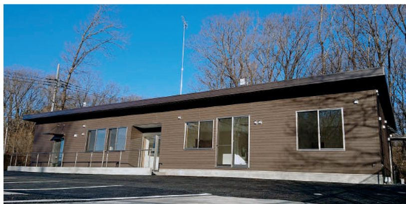
フルール建物全景
