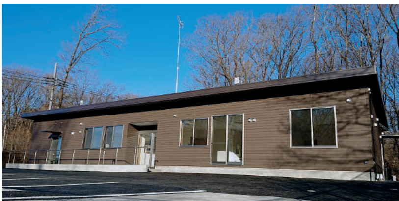
フルール建物全景
